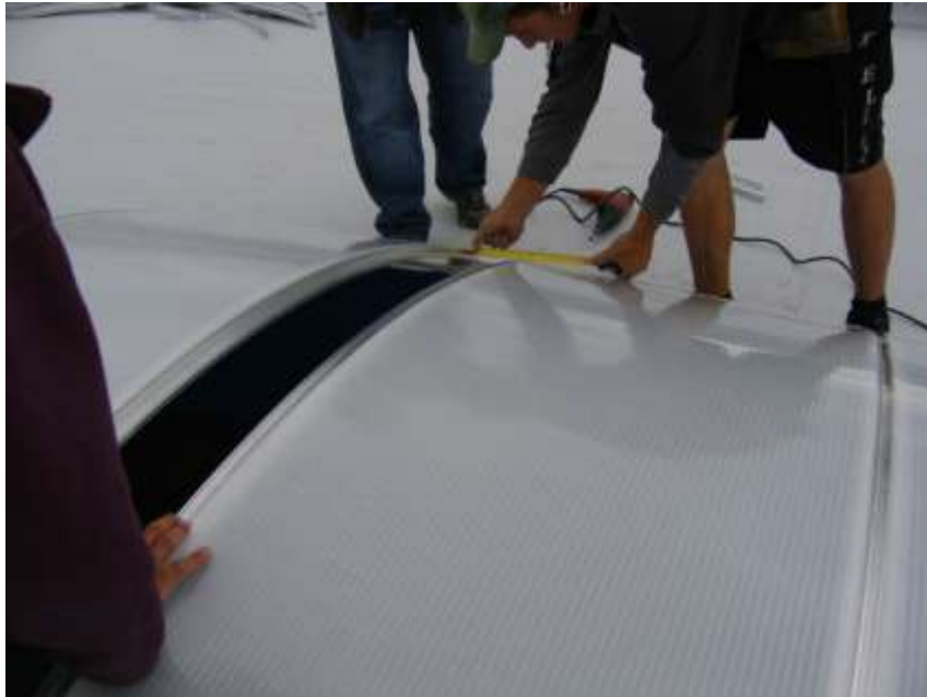
Abb.28 Die Abmessung der Öffnung über die Firste
