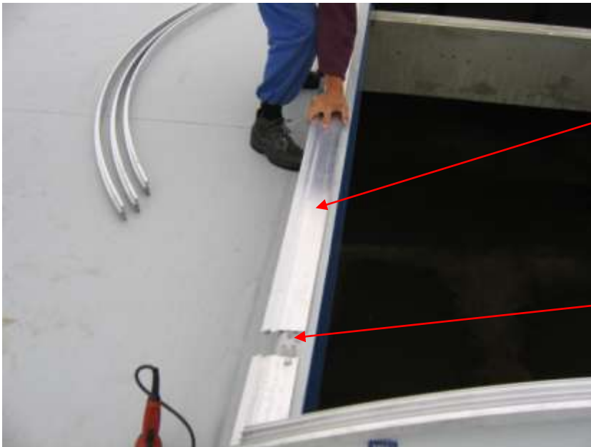
Abb.8 Die Basisprofilvorarbeit zur Montage
