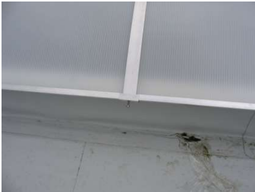
Abb.37 Die Spannschraube vor der Nachspannung
