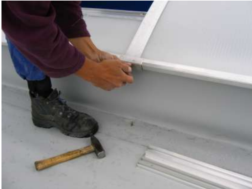
Abb.36 Das Einsetzen der Spannschraube
