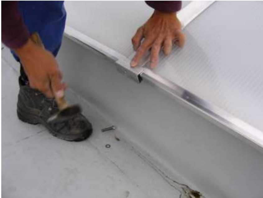
Abb.34 Das Einsetzen des Spannprofils (der Anker)
