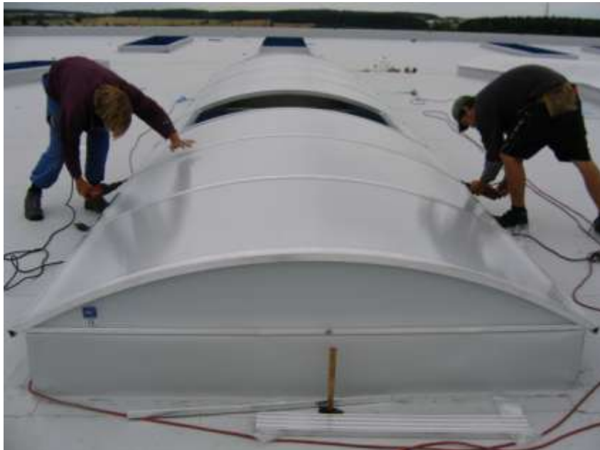
Abb.39 Die Nachspannung der Spansschraube ( am besten in zwei )
