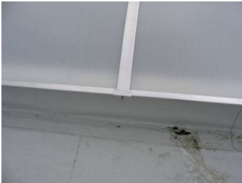
Abb.37 Die Spannschraube vor der Nachspannung
