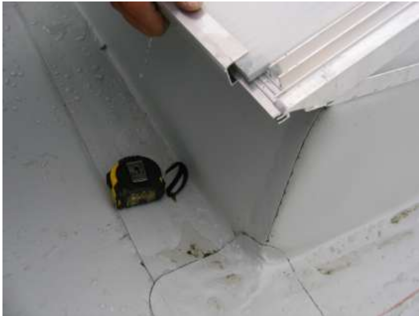
Abb.22 Die Plattebefestigung mit der Verglasungsleiste
