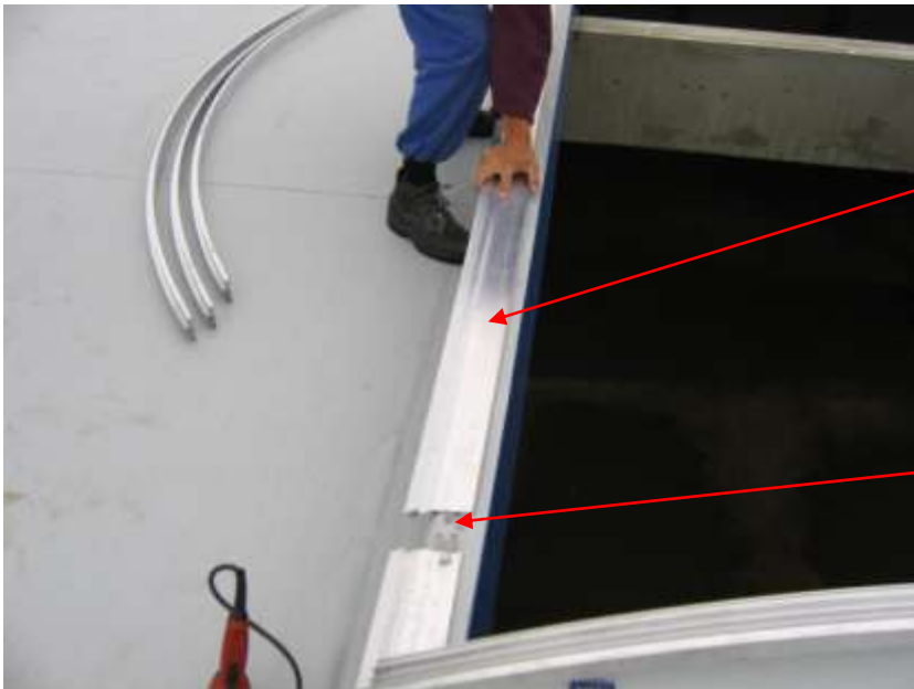
Abb.8 Die Basisprofilvorarbeit zur Montage
