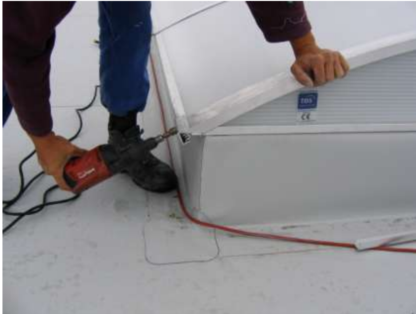
Abb.38 Die Nachspannung der Spansschraube
