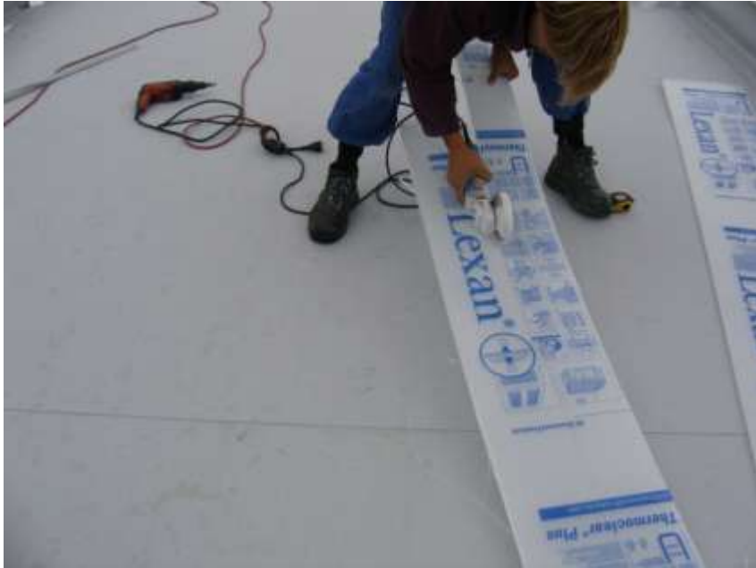
Abb.30 Das Schneiden PC Platten über die Firste,, nach Mass“
