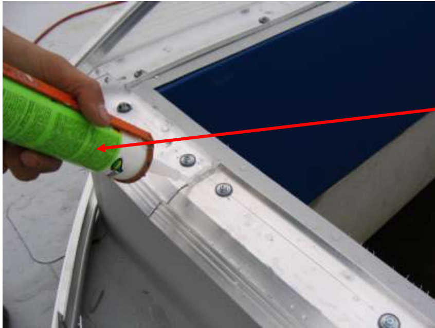
Abb.11 Die Ausdehnungsfuge wird mit dem Silikonkitt gefüllt
