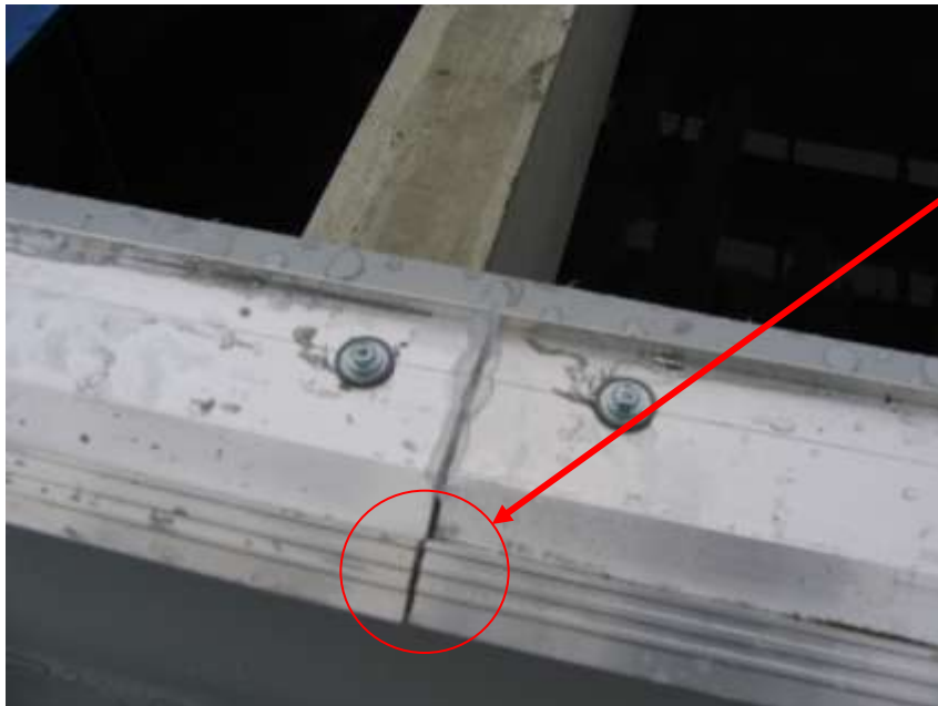
Obr.12 Nichtkitten, für den Wasseablauf frei lassen
