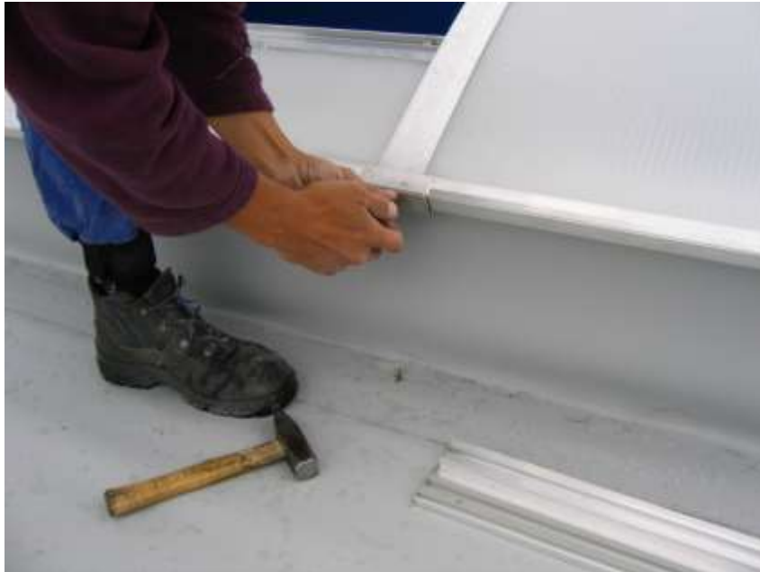
Abb.36 Das Einsetzen der Spannschraube
