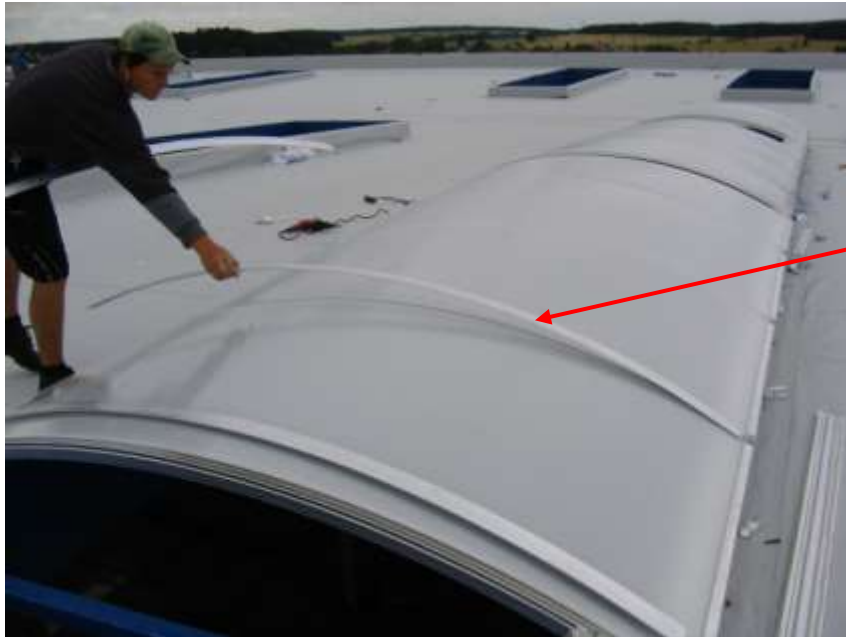
Abb.32 Die Zubereitung des oberen Profiles zur Montage
