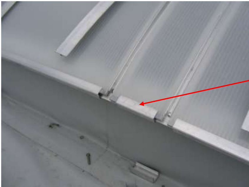
Abb.31 Die befestigte PC Platte über die Firste
