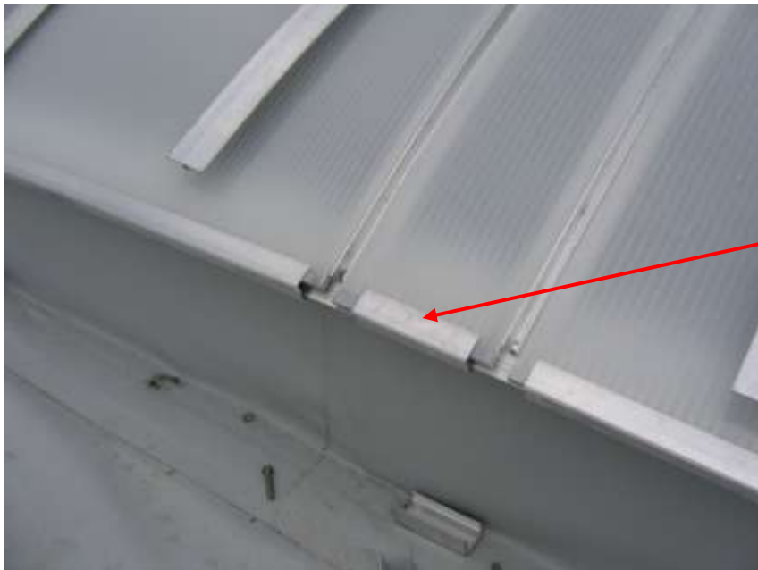
Abb.31 Die befestigte PC Platte über die Firste ( die verkürzte Verglasungleiste )
