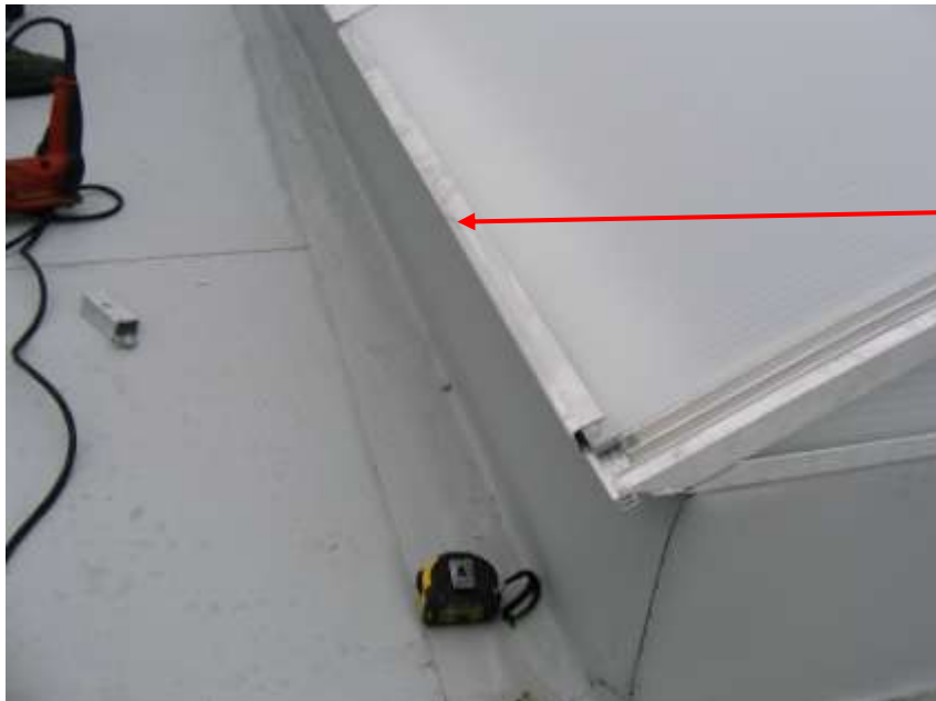
Abb.23 Die PC-Platte ist auf erstem Feld befestigt
