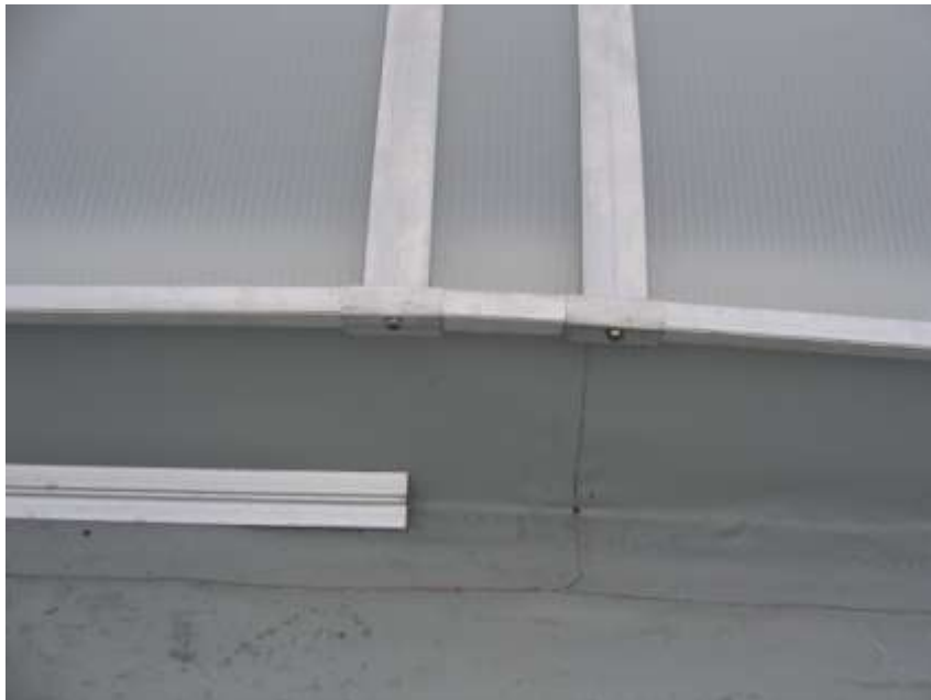
Abb.41 Das richtig befestigte Spannprofil
