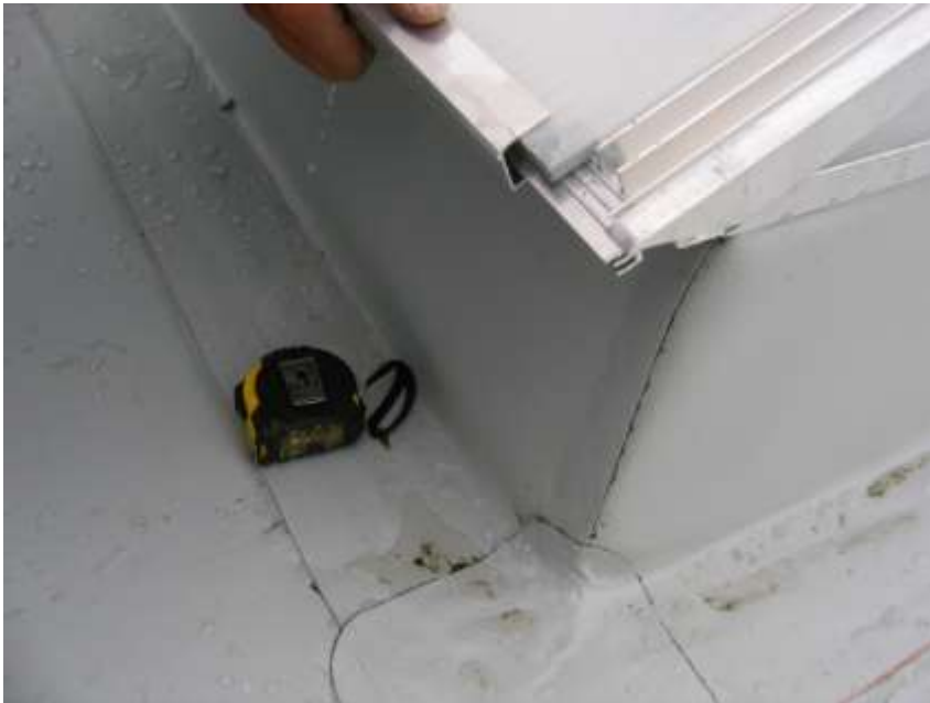
Abb.22 Die Plattebefestigung mit der Verglasungsleiste
