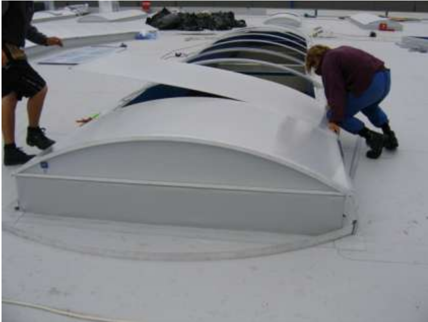
Abb.24 Die PC – Plattelegung auf weiteren Feldern
