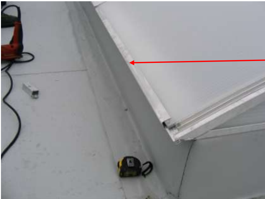
Abb.23 Die PC-Platte ist auf erstem Feld befestigt
