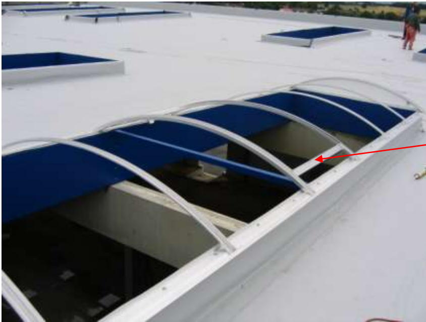
Abb.18 Das Bogenoberlicht vor der Verglasung ( der Tragrahmen unter der Klappe )
