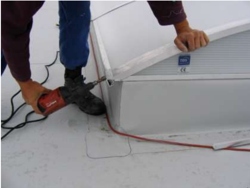
Abb.38 Die Nachspannung der Spansschraube
