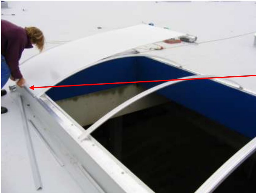
Abb.21 ( PC -Platte immer UV-Schutz nach oben )
