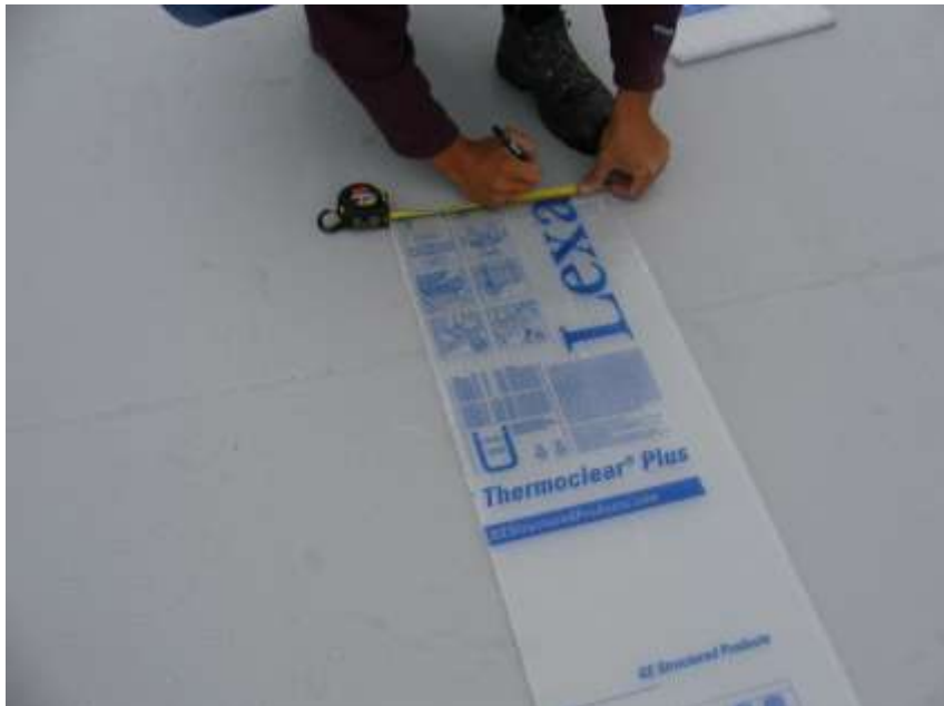
Abb.29 Die Abmessung der PC Platte über die Firste
