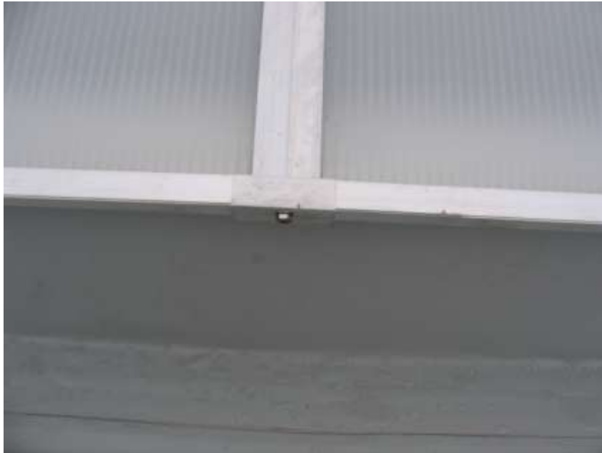
Abb.40 Das richtig befestigte Spannprofil
