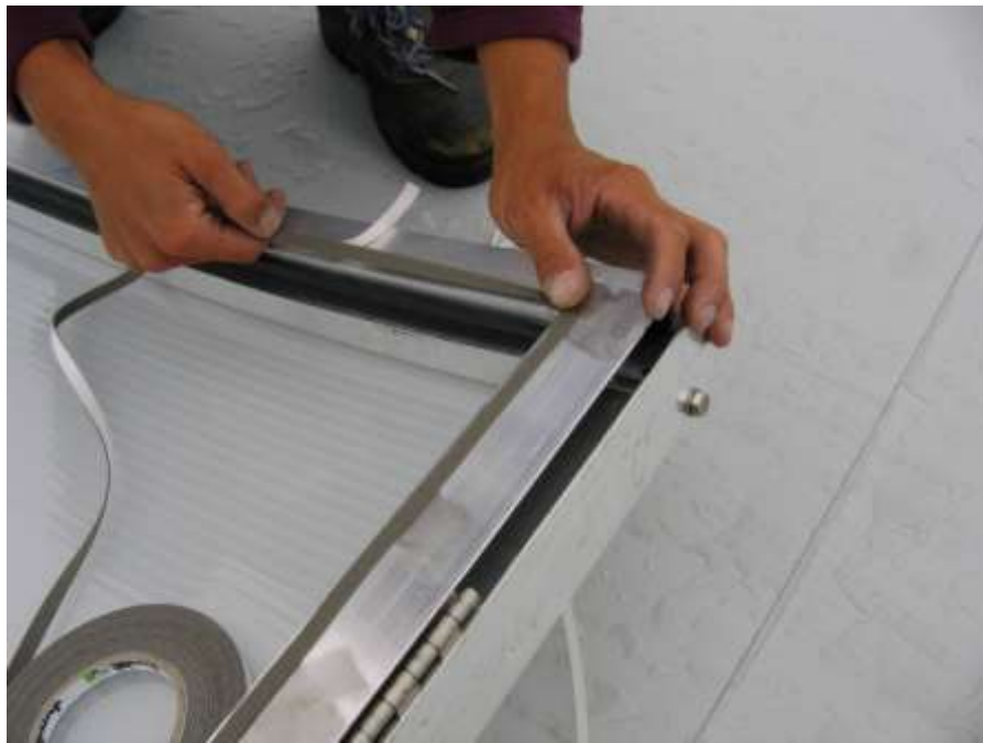
Abb.3 Das Kleben der Dichtung ( über die Ecke )
