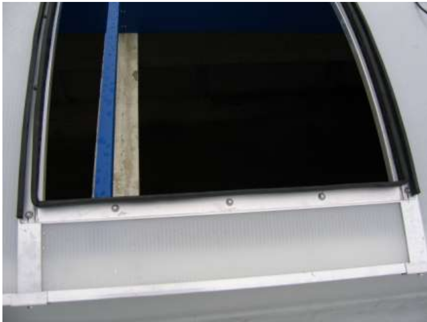
Abb.17 Die richtige Platzierung der Schrauben ( die vordere Seite )
