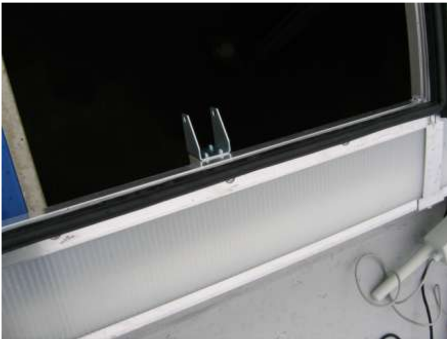
Abb.20 Die richtig befestigte Motorkonsole
