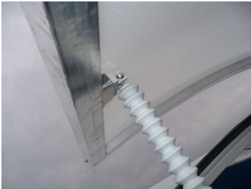
Abb.26 Die Befestigung der Motorzugstabe an den Flügel
