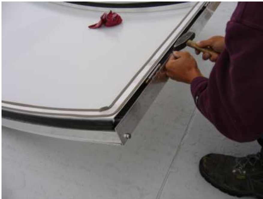
Abb.9 Man montiert den Flügel vom Rahmen ab
