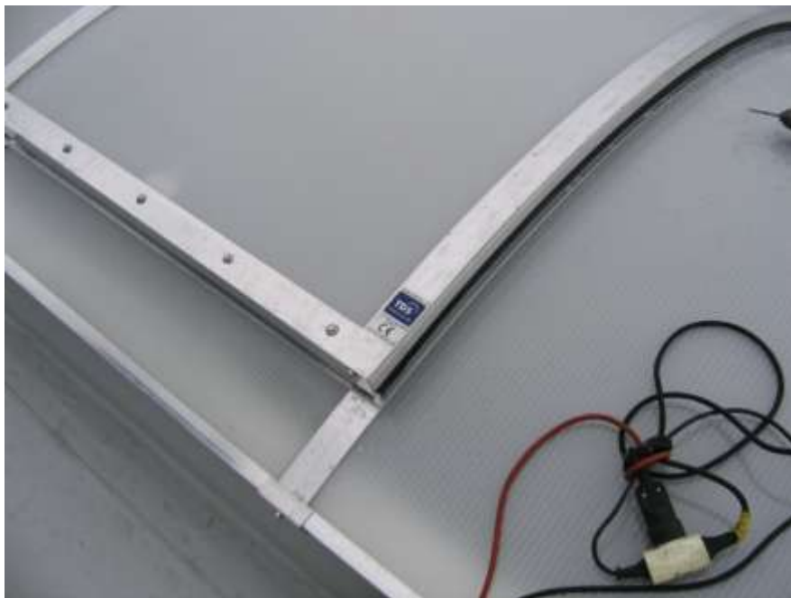
Abb.25 Dichtung kontrollieren
