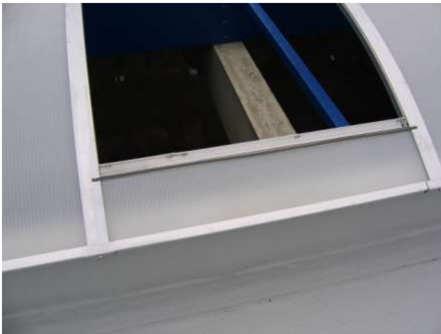
Abb.7 Das richtig angeklebte Dichtungband
