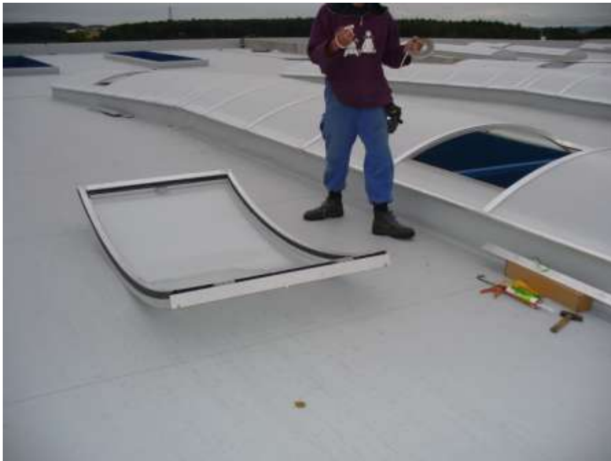
Abb.1 Die Einrichtung der Klappe zur Montage
