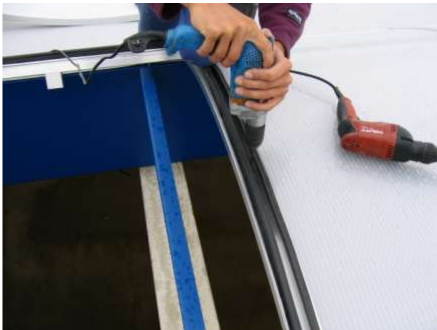
Abb.14 Von Gipfel schraubt man die Klappe zu einer Seite und dann zu zweiter Seite ( der Schraubenabstand 200 mm)
