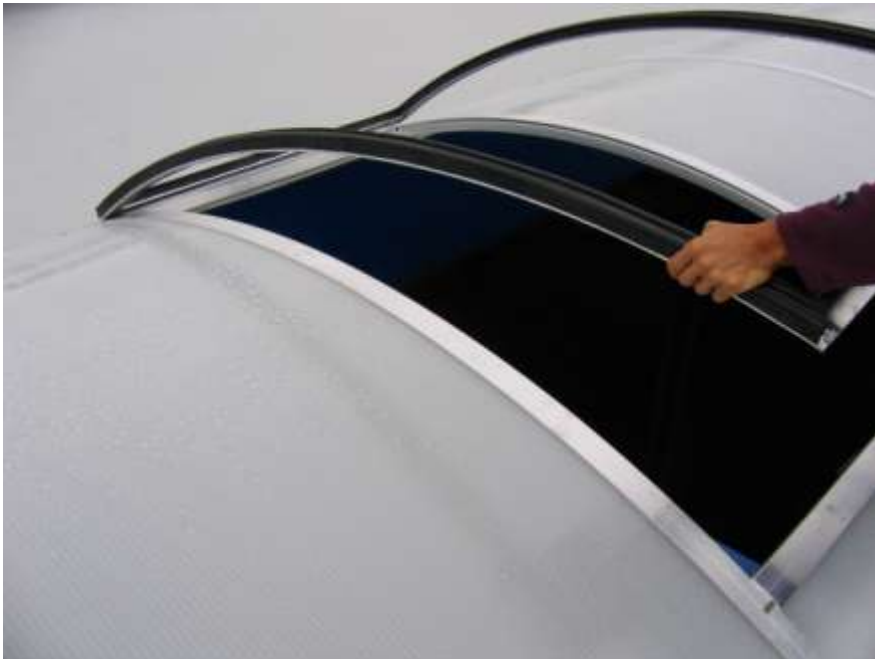
Abb.12 Man legt den Klappenrahmen an den Tragrahmen
