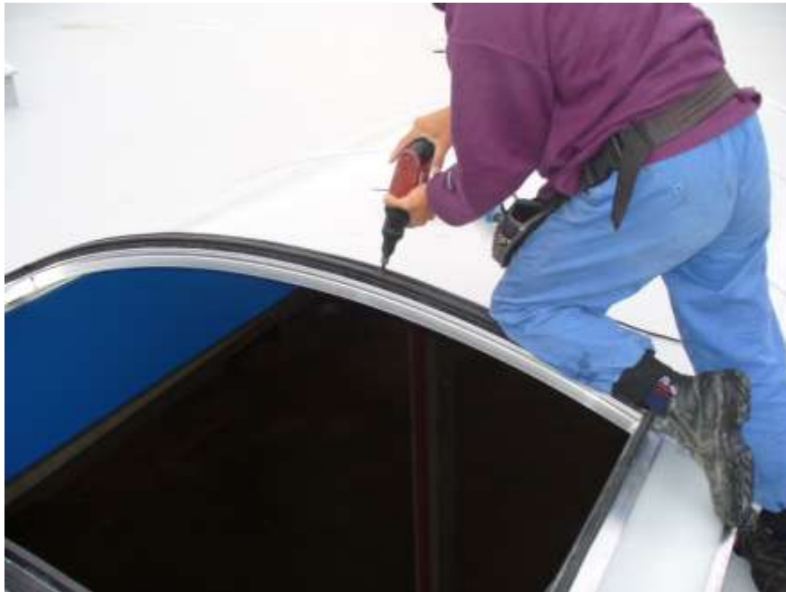
Abb.13 Man verschraubt den Klapperahmen zum Tragrahmen
