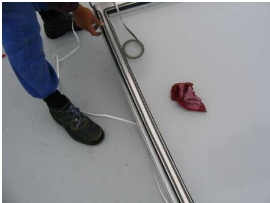
Abb.4 Das Kleben der Dichtung ( zweites Band )
