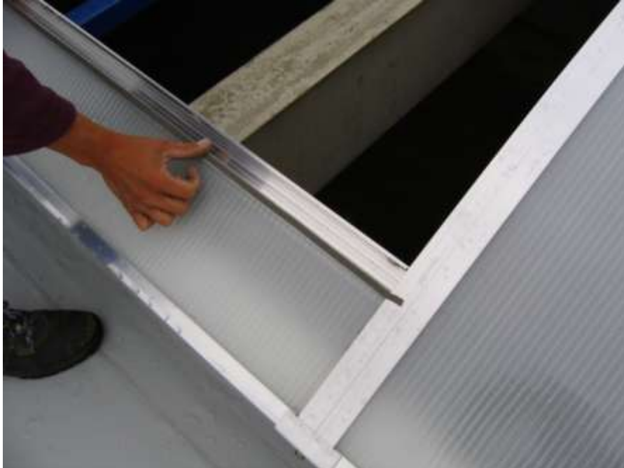
Abb.6 Das Kleben des Dichtungbands auf den Untertragprofil
