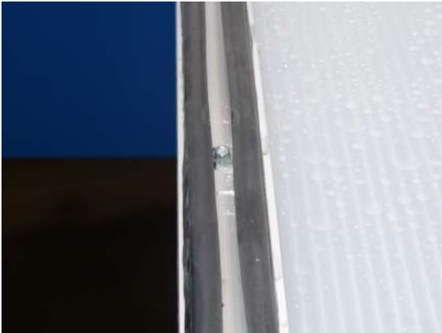
Abb.15 Der richtig angeschraubte Rahmen ( die Schraube in der Mitte der Leiste )
