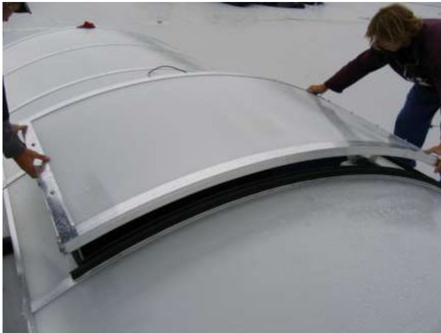
Abb.23 Der Ansatz des Lüftungsflügels
