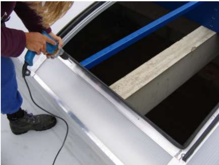
Abb.16 Das Lochevorbohren
