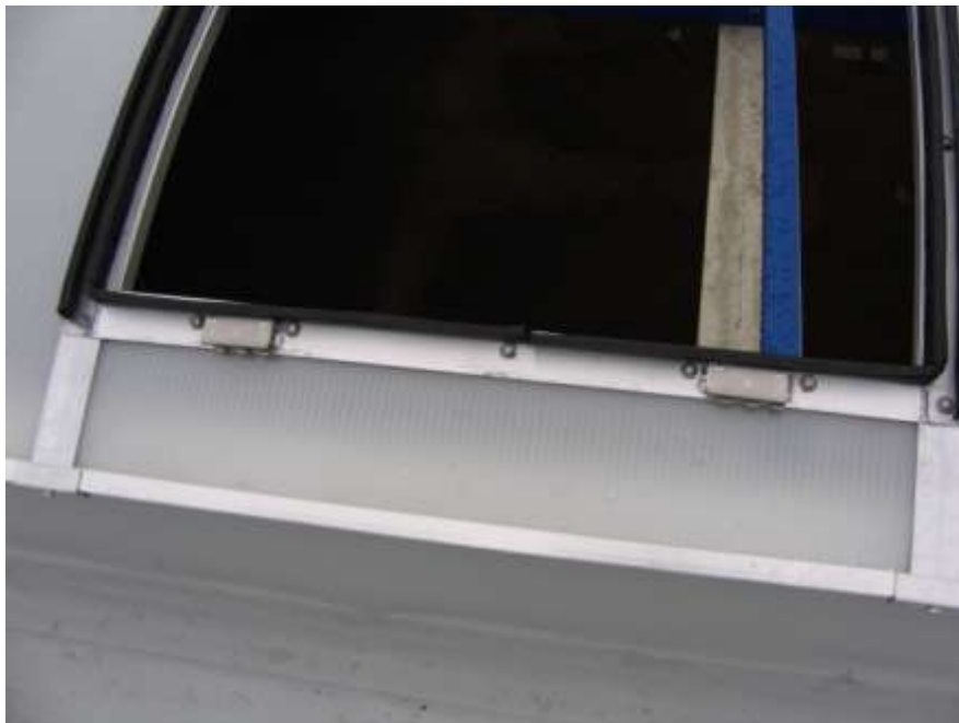
Abb.18 Der richtige Platzierung der Schrauben ( die hintere Seite )
