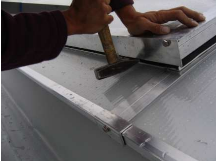
Abb.24 Man befestigt den Flügel, montiert die Scharniere zurück
